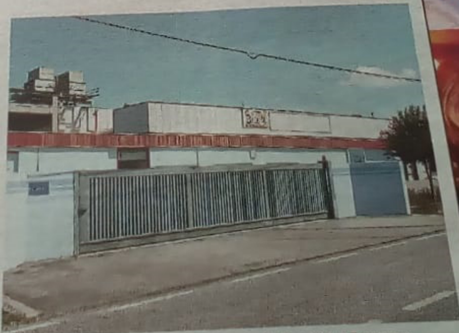
NUOVO Lo stabilimento produttivo della Bechèr a Ponzano
